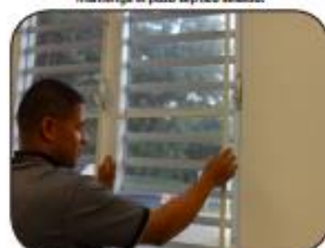
Instale o repare la malla o tela metálica de ventanas y puertas.
